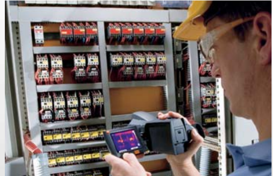
Industriell termografering med testo 876
