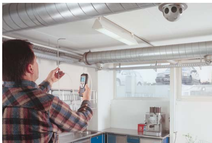
Injustering av tilluft i kök.
