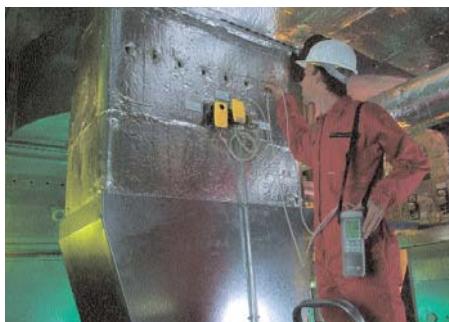
Noggrann pitotrörmätning (prandtrör) med beräkning av punkt- och tidsmedelvärde
